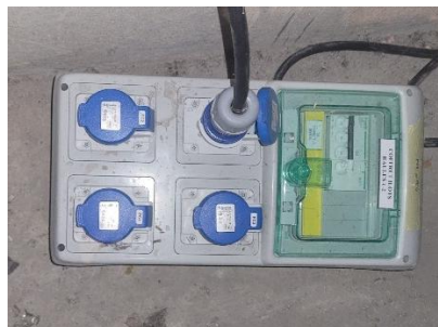
Boîtier 32 tri avec sortie 16 en P17, cette fois-ci il y a 16A par prise
