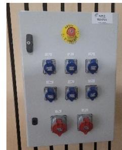
Armoire au mur où nous pouvons brancher directement du 32A en P17 ou plusieurs 16A
